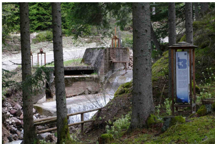
A valle di Pampeago la presa d'acqua dell'acquedotto che portava all'impianto l'acqua necessaria per il trattamento mediante flottazione.
