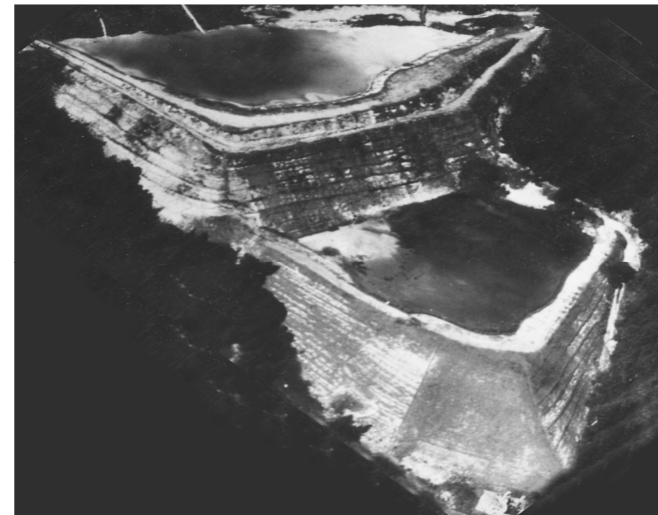
Gli errori progettuali e di costruzione dei bacini che ne determinarono la condizione di cronica instabilità e il crollo.
