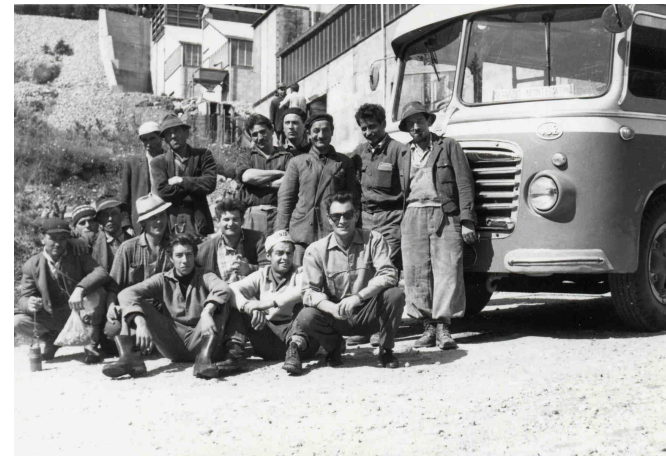
Scava nuove gallerie, costruisce un acquedotto, una teleferica per il materiale, una seggiovia per i minatori, l'impianto di trattamento, le case a Tesero per i tecnici, e assume oltre 100 dipendenti che vengono trasportati dai vari paesi della valle all'impianto di Prestavèl con un autobus riservato.
