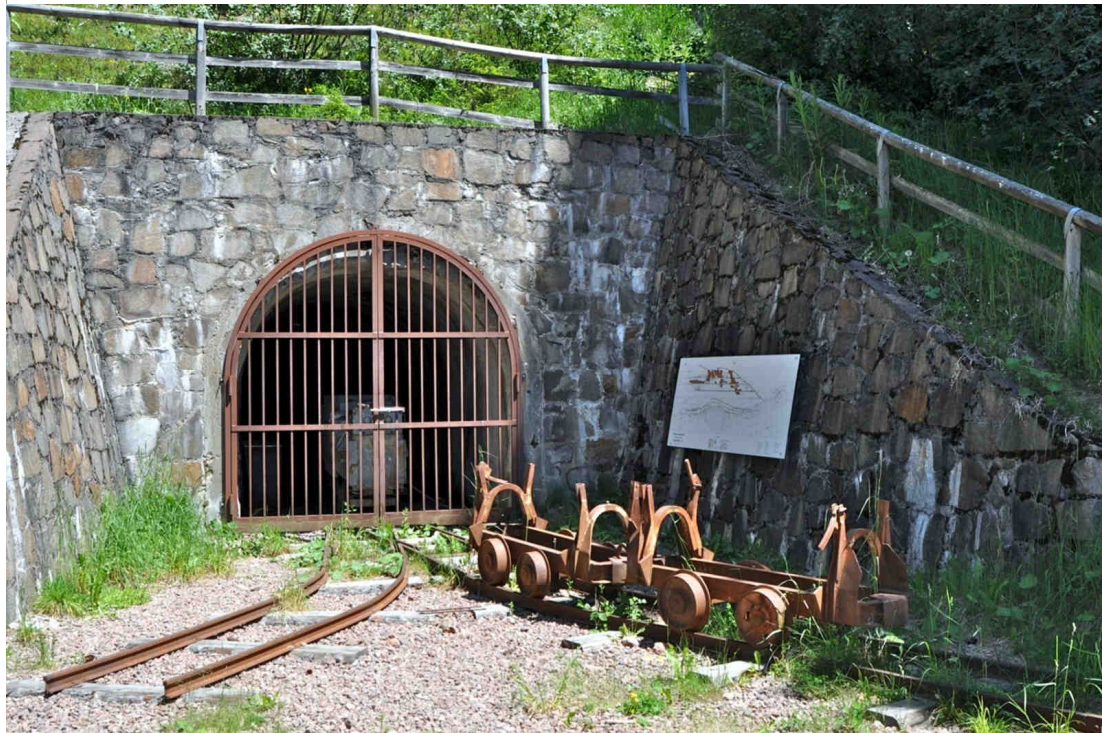
L'imbocco della galleria di miniera di quota 1550.
