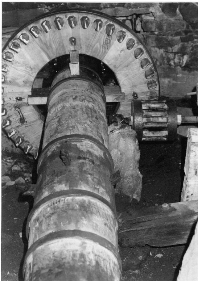
6. Essendoci in questa fucina una sola ruota, serviva l'ingranaggio per trasmettere il movimento anche alla mola ad acqua. Visibili in primo piano, sull'asse, i denti di ferro che, girando, facevano alzare ed abbassare il maglio.
