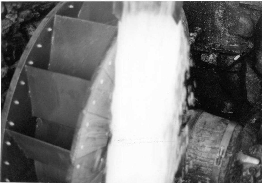
5. La ruota a cassetto è stata rivestita in lamiera. Da notare il perno poggiate direttamente sul sasso: per diminuire l'attrito, nell'incavo del sasso si metteva dell'olio.
