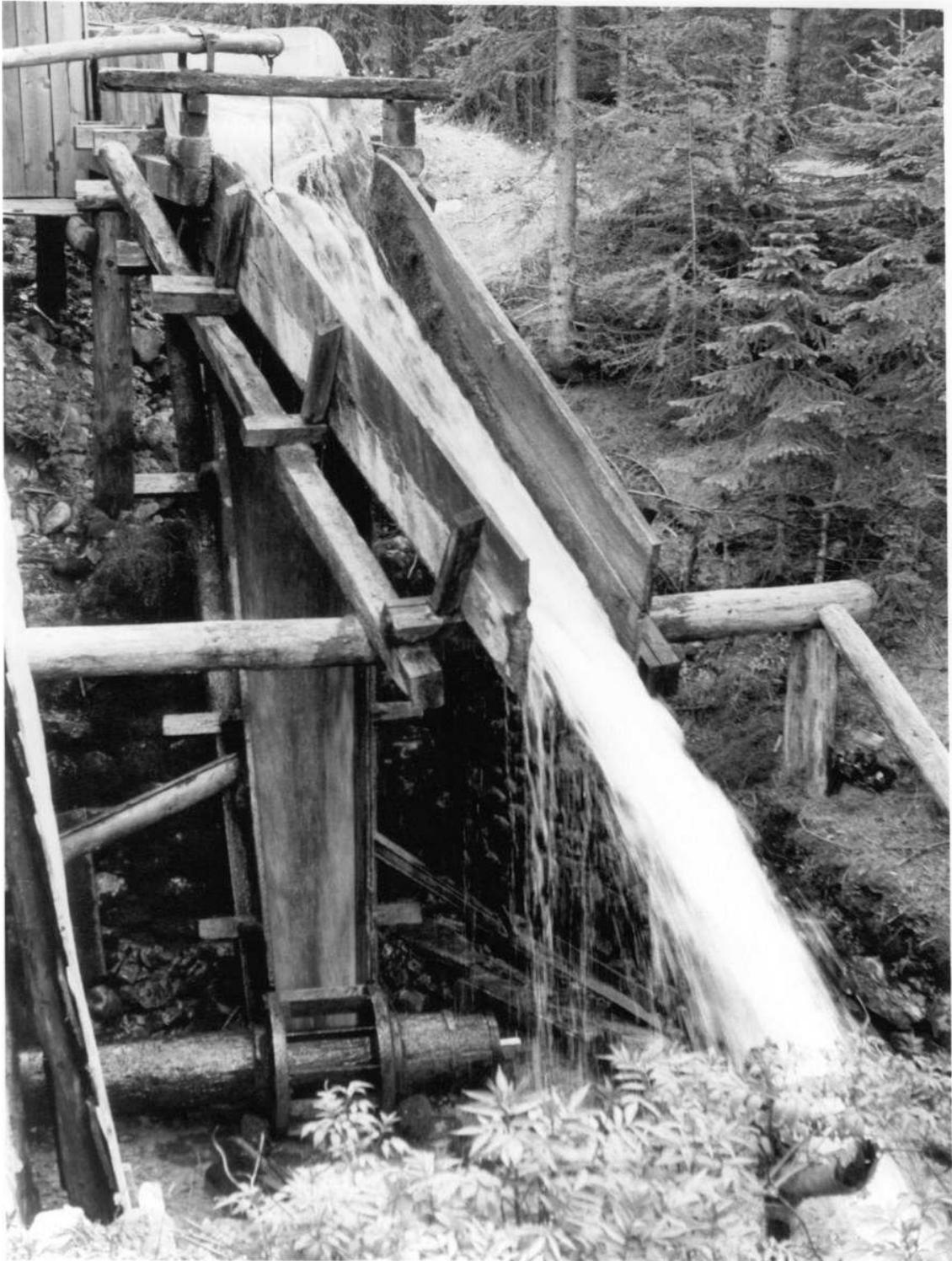
4. Doccia «zitón» e ruota a riposo; l'acqua è deviata in un canale di scarico; visibile in alto la stanga che dà o toglie l'acqua alla ruota.
