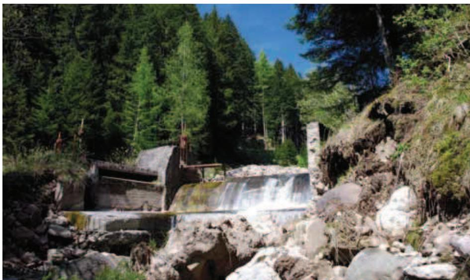
*Sopra* Quello che rimane oggi della presa d'acqua sul rio Stava a valle di Pampeago. L'acquedotto portava l'acqua all'impianto di flottazione e aveva una portata di 65 litri al secondo.
