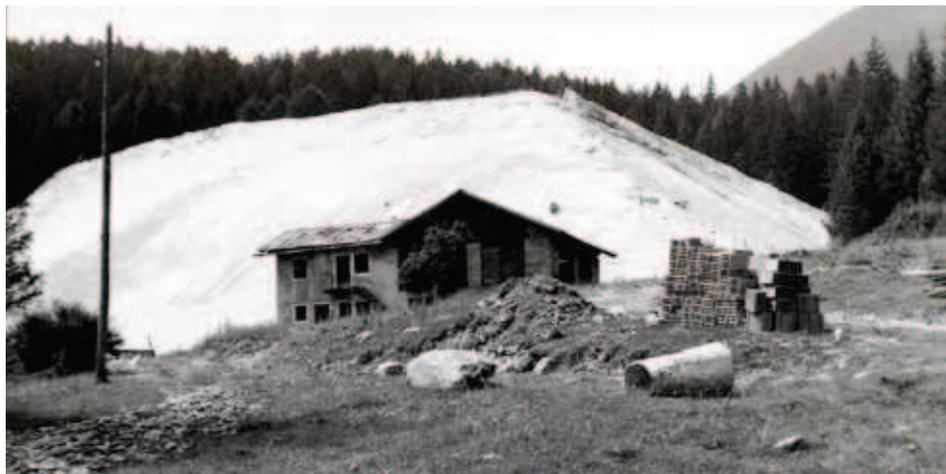
I bacini di decantazione sono discariche minerarie per la decantazione dei fanghi residui della lavorazione del minerale mediante flottazione o lisciviazione. Servono per il deposito, la consolidazione e lo stoccaggio degli scarti della lavorazione mineraria e per il recupero dell'acqua utilizzata nella lavorazione.
