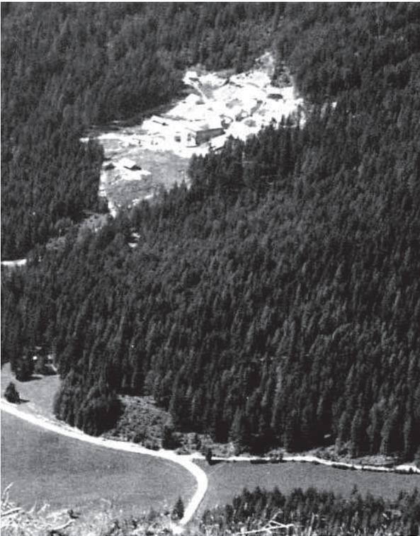
*In alto* Gli impianti di Prestavè e la zona di Pozzole con il primo bacino di decantazione nel 1964. Il fango residuo della lavorazione veniva portato al bacino di decantazione mediante una condotta lunga circa 400 metri.
