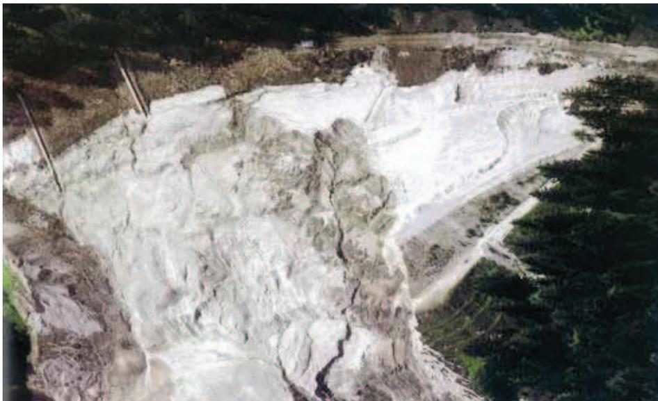
*Sopra* Quello che rimaneva del bacino superiore dopo il crollo. Al momento del crollo i bacini erano alti complessivamente oltre 50 metri e contenevano circa 300 mila metri cubi di materiale. A sinistra si nota la berma realizzata nel 1975 per addolcire la pendenza dell'argine.
