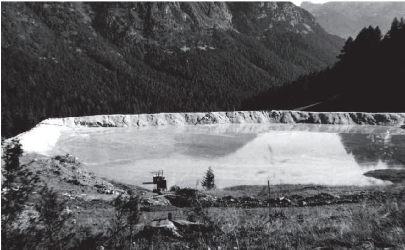
*Sopra* Il bacino inferiore nel 1969. Si nota in primo piano lo scavo per la costruzione dell'argine del secondo bacino che venne impostato a monte del primo senza ancoraggio e senza alcun elemento drenante.
