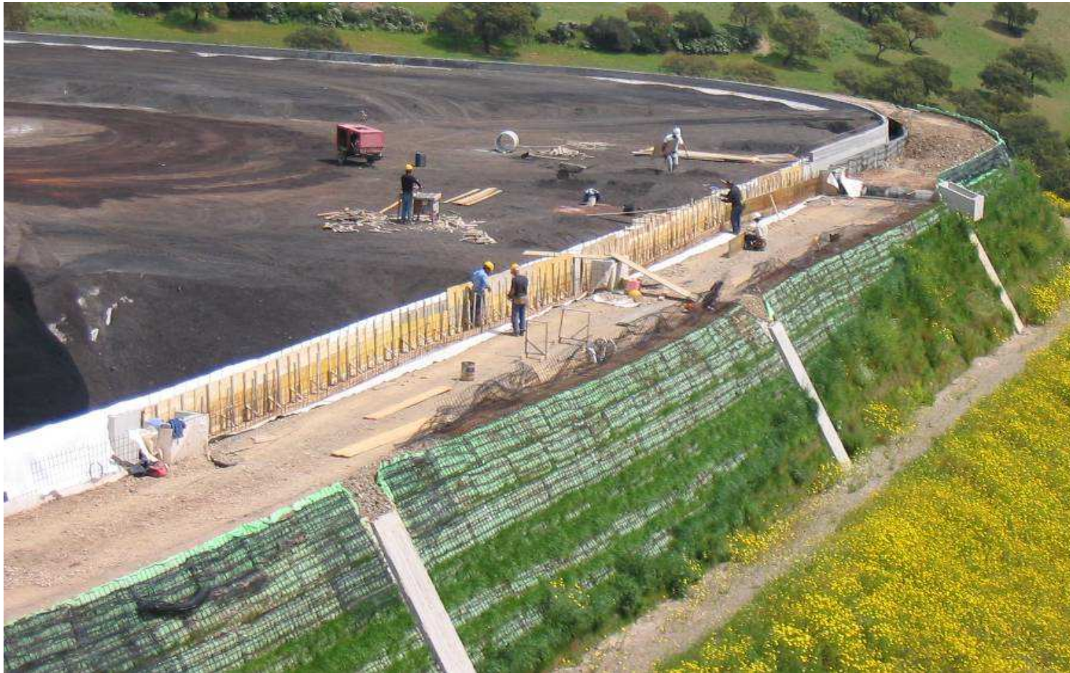
Costruzione della trincea in cemento
